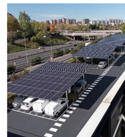
EDIFICIO IRIS MADRID
