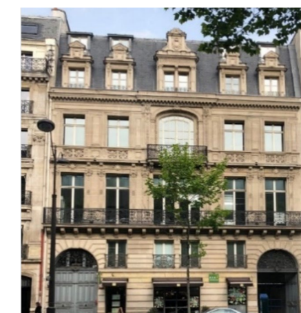
EDIFICIO AVENUE KLEBER 8 PARIS
